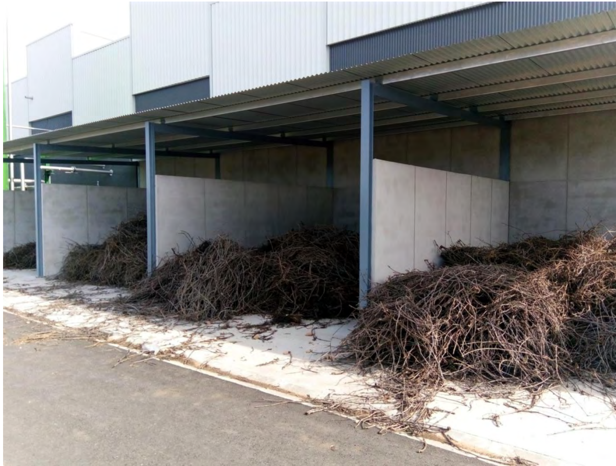
Trojes de almacenamiento de biomasa lignocelulósica
