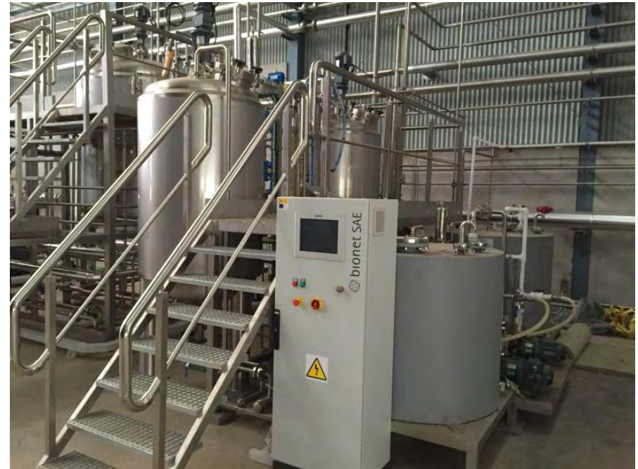
Sistema de adición de estériles: nutrients, ácido, base y antiespumante
